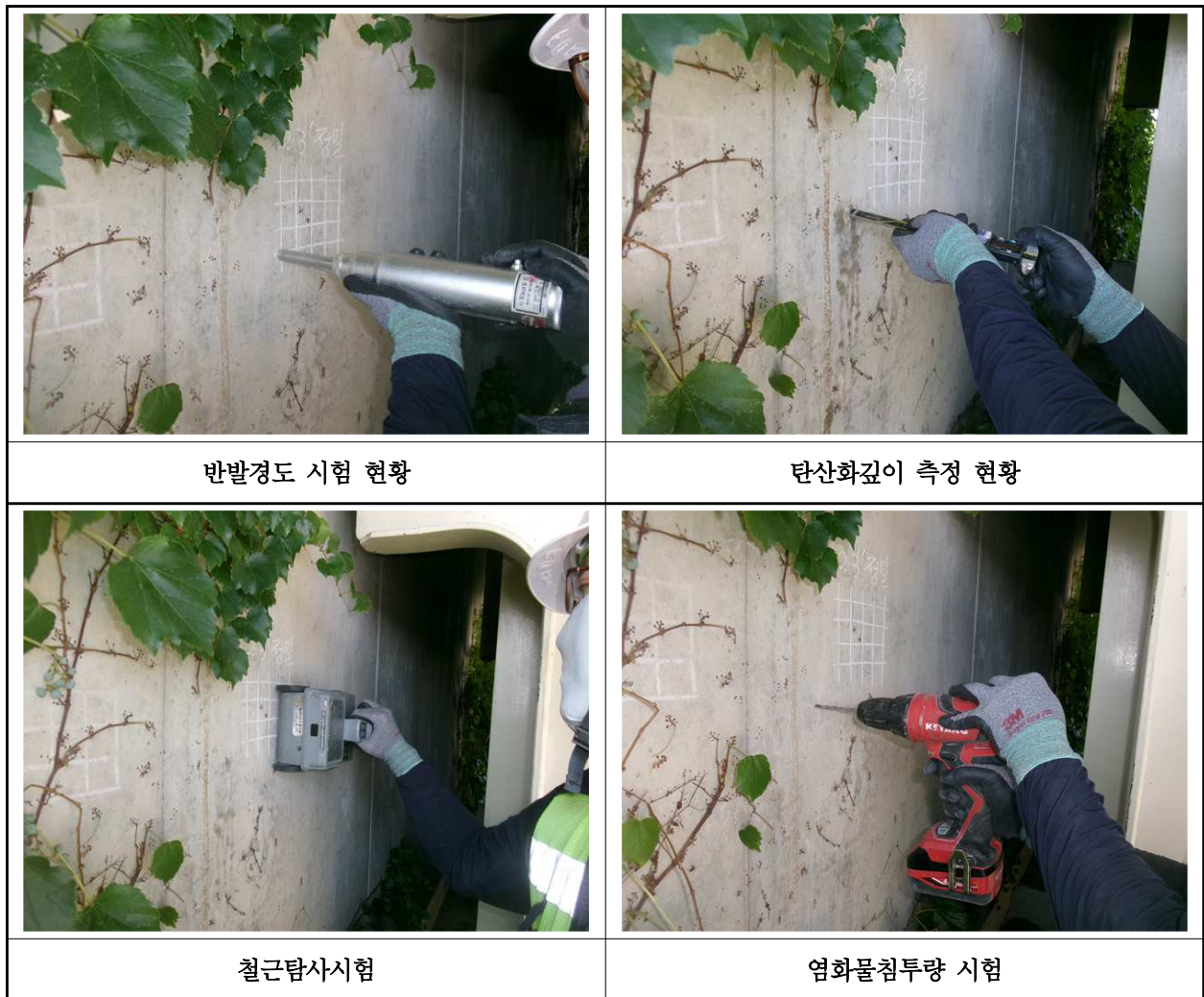
【사진 23.4.1】 콘크리트 내구성조사 현황
