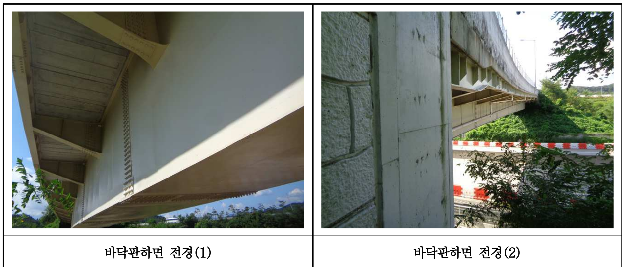
【사진 23.3.2】 바닥판하면 전경
